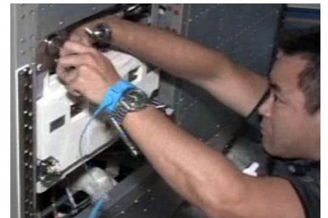
「きぼう」の低温冷却水系のポンプを交換する星出宇宙飛行士 (出典: JAXA/NASA)
