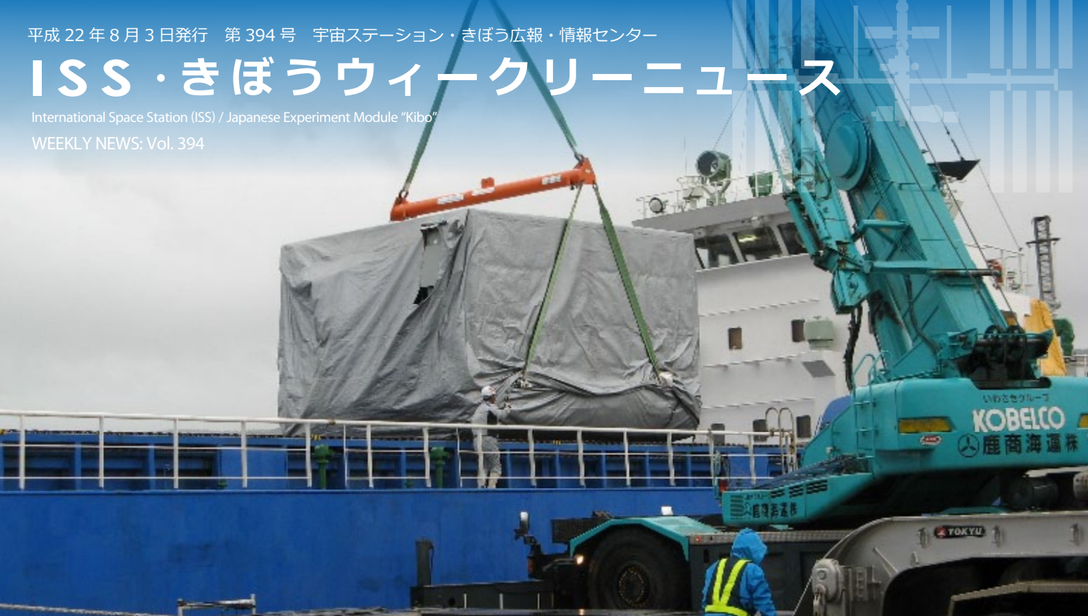
島間港に下ろされる HTV2 号機（電気モジュールおよび推進モジュール）（出典：JAXA）
