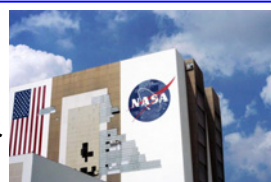
約850枚の外壁パネルが吹き飛ばされました
