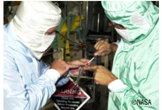
酸素漏れの発生した配管 （交換作業にて）
