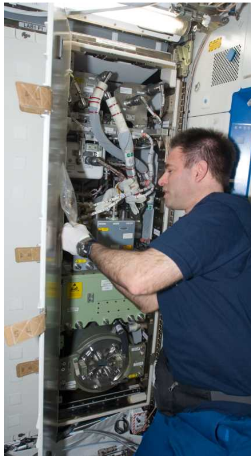
図4.2-3 米国の酸素生成装置(OGS)
