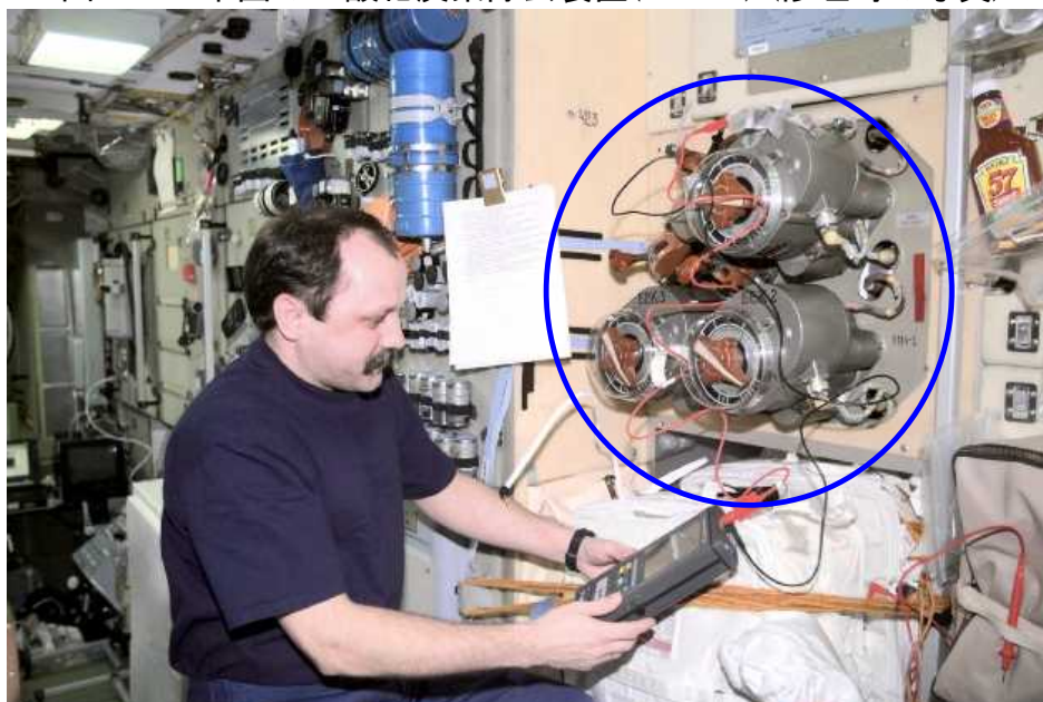
図4.2-5 ロシアのVozdukh (表面に見えているのはパルプパネルのみで、本体はパネルの背後に収納)
