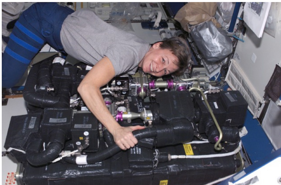
図4.4.4-10 米国の二酸化炭素除去装置(CDRA) (修理時の写真)
