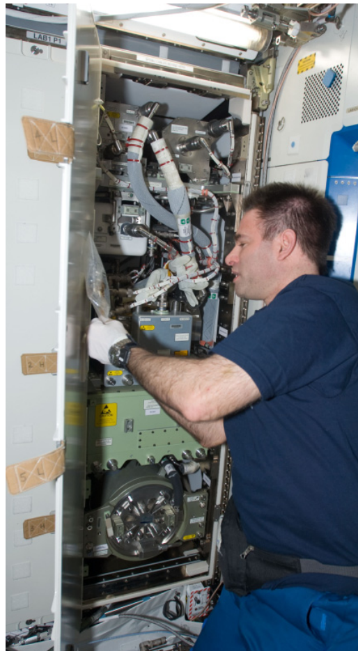
図4.4.4-9 米国の酸素生成装置(OGS)
