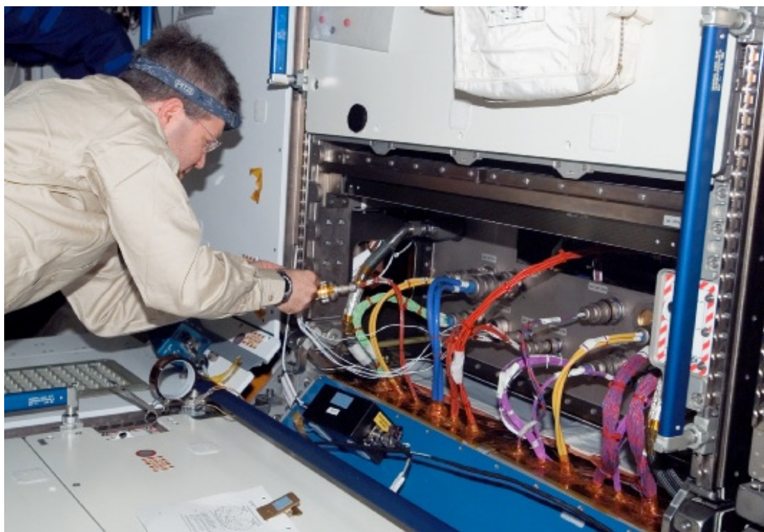
図4.3.4-12 ハーモニーの電力・通信配線のトラブルシュート (故障箇所の究明)
