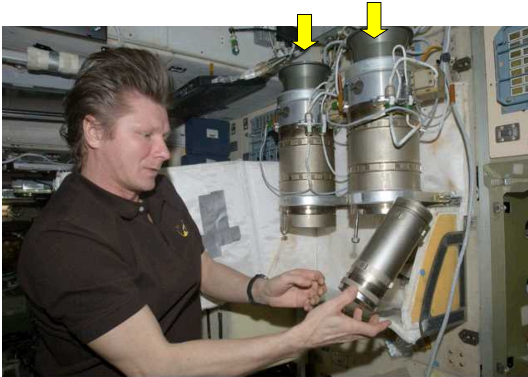
図4.2-2 ズヴェズダ内に設置されているSFOG容器2本(矢印)(NASA)
