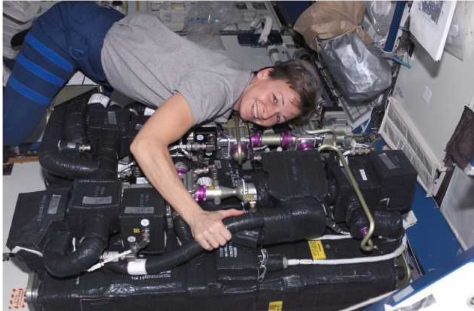
図4.2-4 米国の二酸化炭素除去装置(CDRA) (修理時の写真) (NASA)
