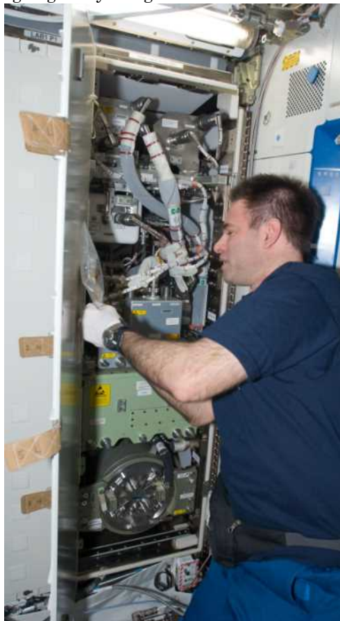
図4.2-3 米国の酸素生成装置(OGS)(NASA)
