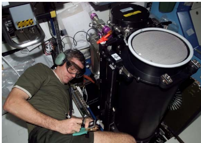
図3.4.2-6 米国の有害ガス除去装置(TCCS) (修理時の写真)
