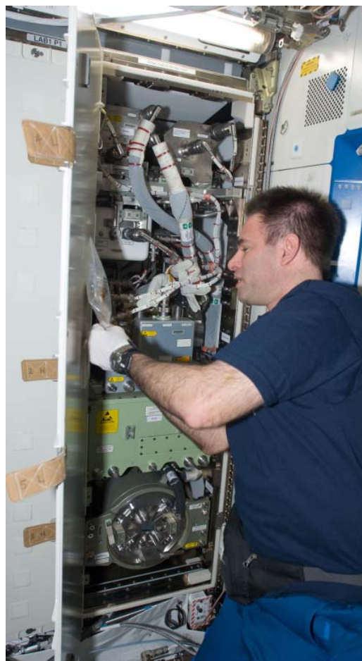
図3.4.2-3 米国の酸素生成装置(OGS)
