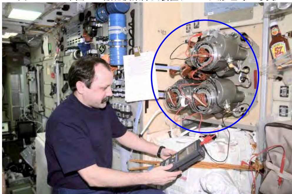
図3.4.2-5 ロシアのVozdukh (表面に見えているのはバルブパネルのみ)
