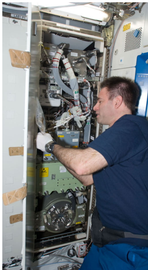
図4.4.2-3 米国の酸素生成装置(OGS)
