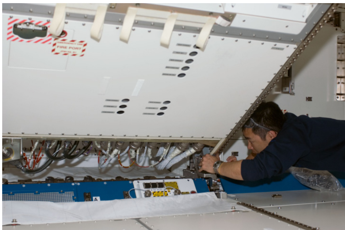
図4.3.4-11 きぼう内のラックの電力・通信・流体配管の接続作業
