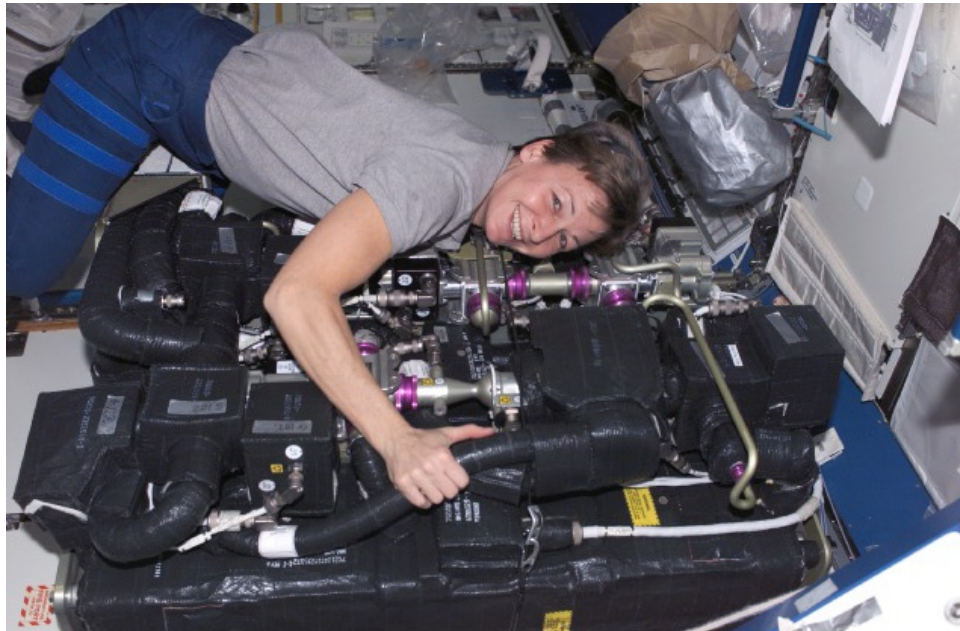
図4.4.2-4 米国の二酸化炭素除去装置(CDRA) (修理時の写真)
