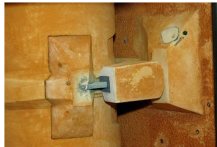
改修のために断熱材を切除した支持ブラケット
