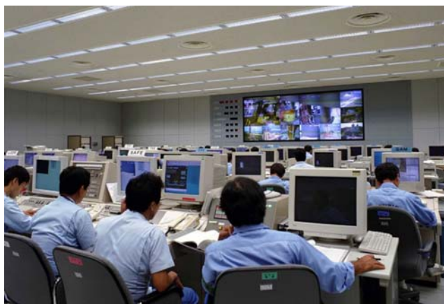
種子島宇宙センター 大型ロケット発射場 発射管制室
