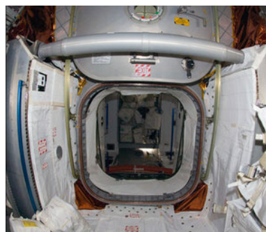
ハーモニー地球側のCBMに結合中の「レオナルド」(多目的補給モジュール)の内部からハーモニー側を見た様子
