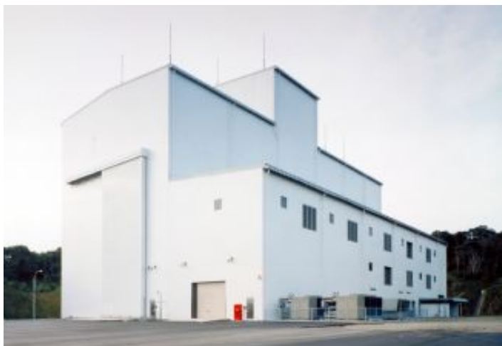
図1.3.1-7 第2衛星フェアリング組立棟 (SFA2)
