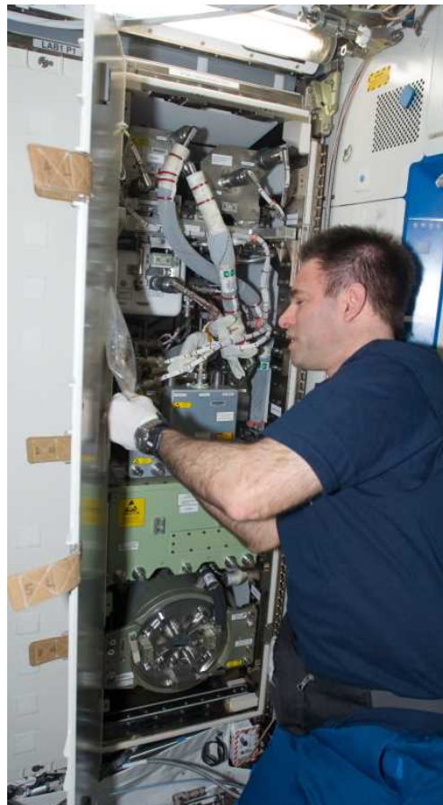
図4.2-3 米国の酸素生成装置(OGS)
