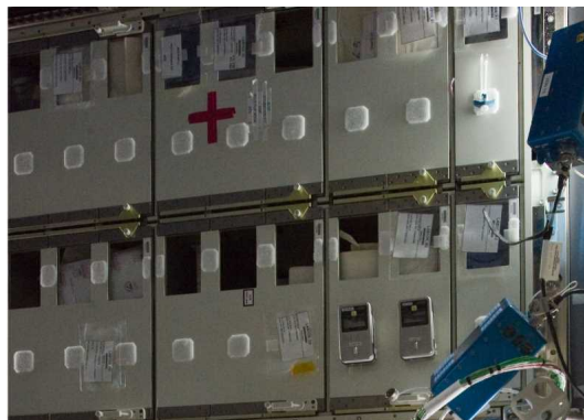
図3.3-8 デスティニー内のクルー健康管理システムラック(CHeCS2ラック)
