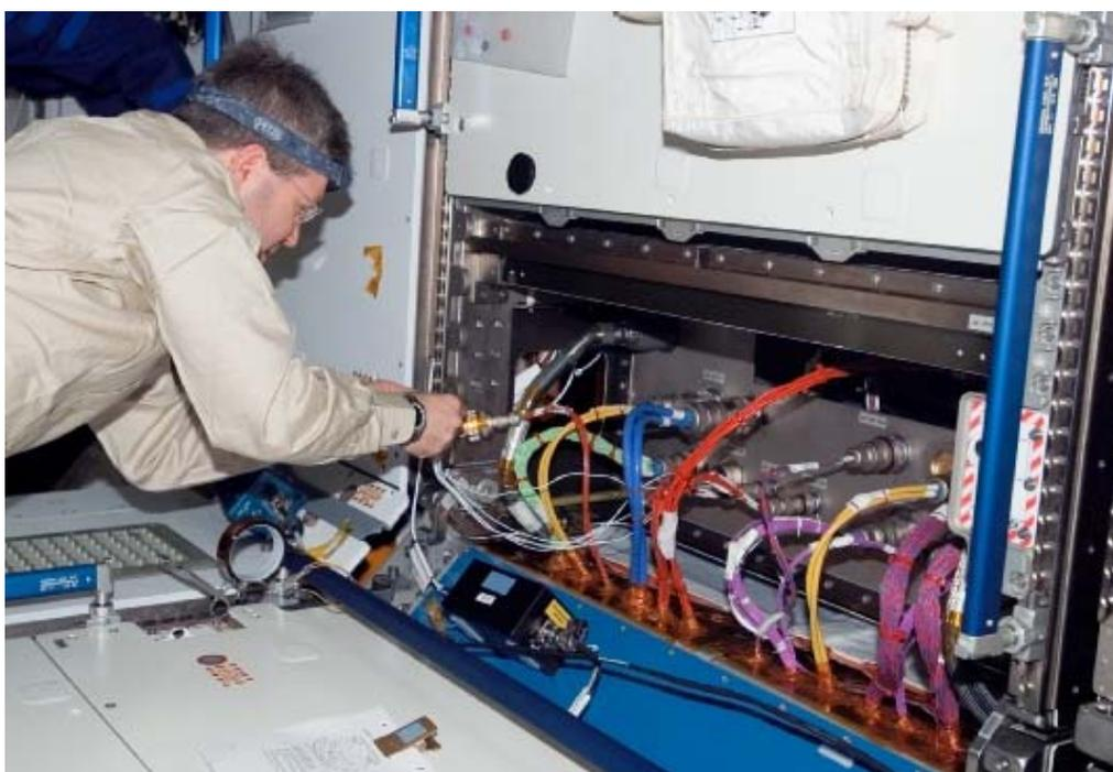
図3.3.4-12 ハーモニーの電力・通信配線のトラブルシューティング
