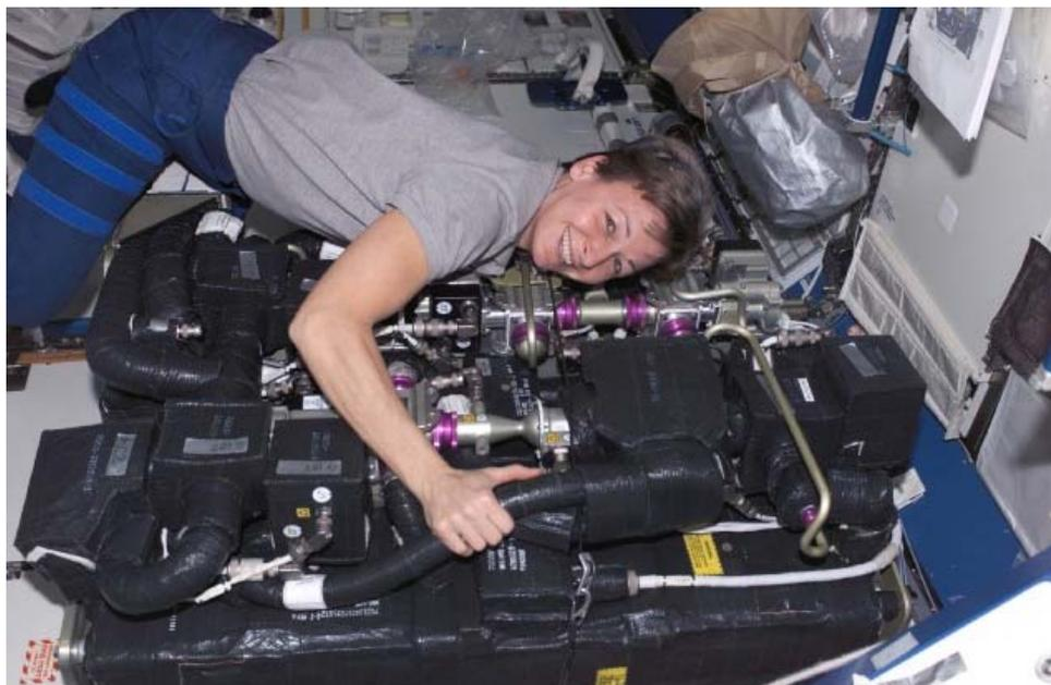
図4.4.2-4 米国の二酸化炭素除去装置(CDRA) (修理時の写真)
